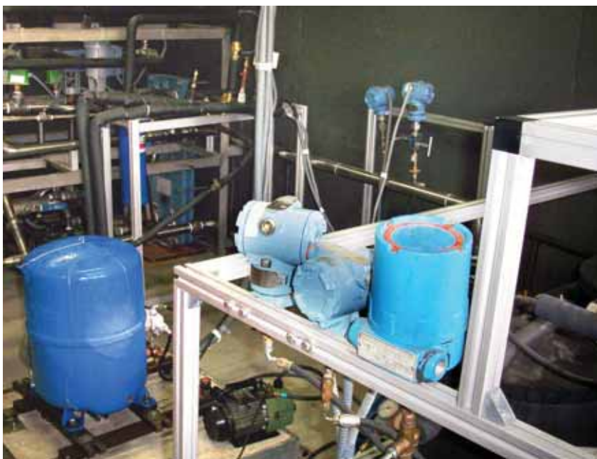
Laboratorio de ensayo de componentes de refrigeración.
