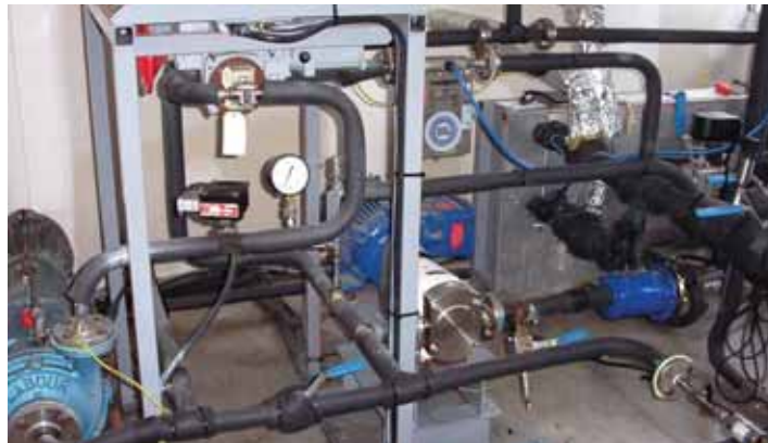
Instalación de ensayo de intercambiadores compactos.
