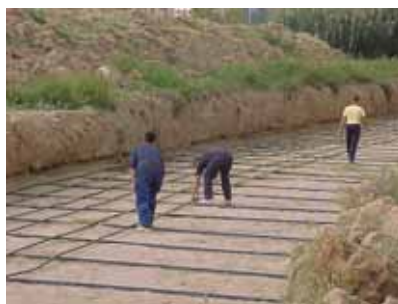
Geotermia: intercambiador horizontal.
